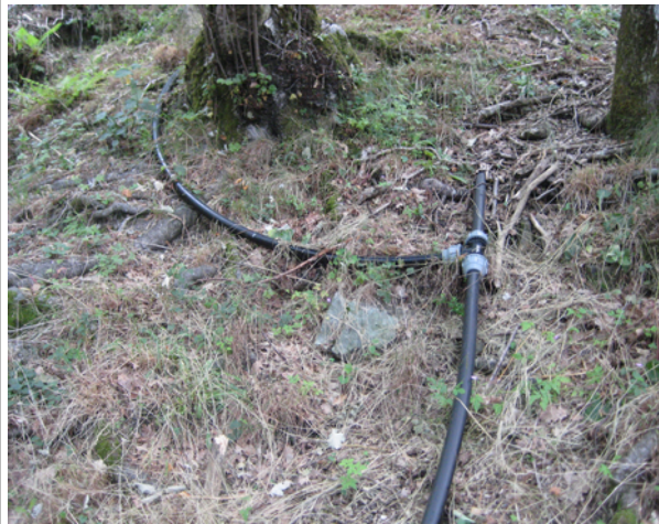
Canalisation en provenance des émergences n°1 et 3
