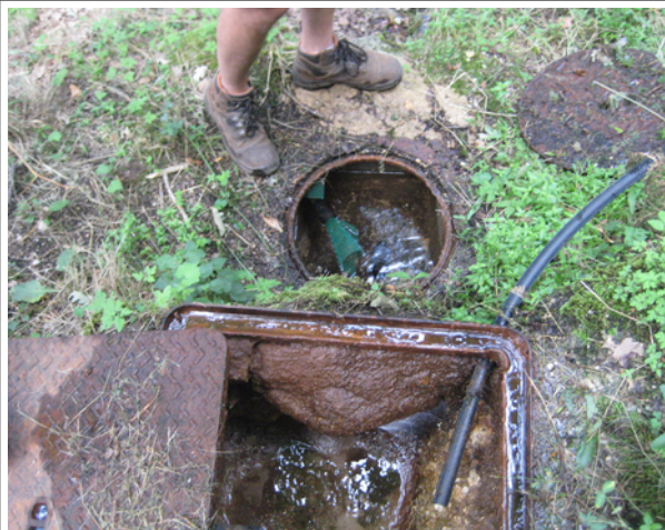
Émergence n°2 (avec arrivée de l'émergence n°5) et émergence n°3
