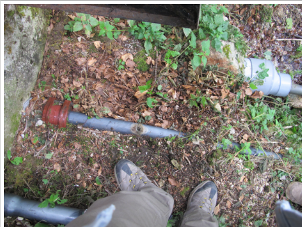
Canalisation sortant du captage
