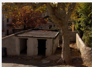
Début des travaux
