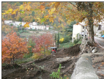
Travaux parking de Serres
